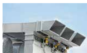
Rökutsugsfläktar / rökluckor
