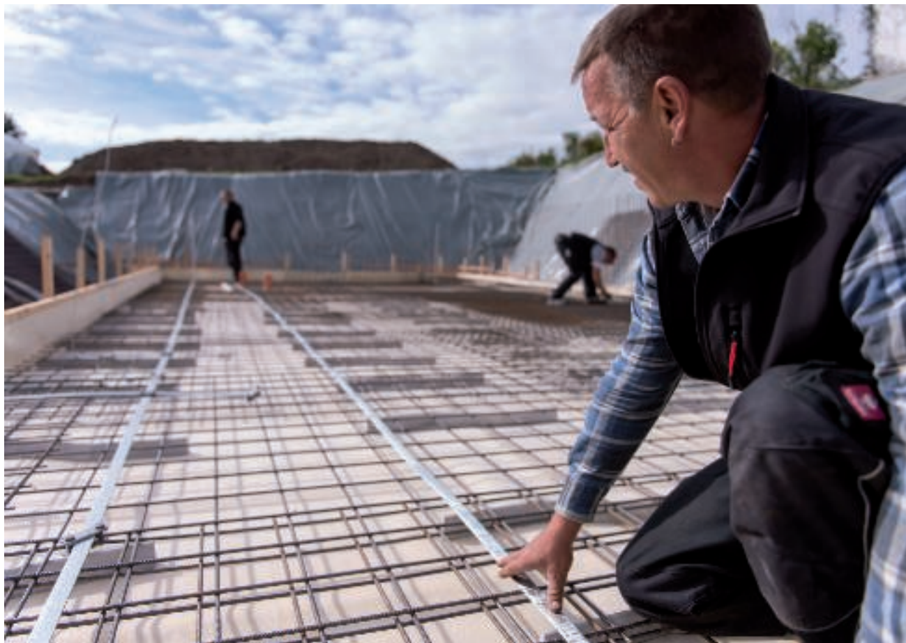
Placering av fundamentjordning
