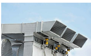
Rökutsugsfläktar / rökluckor
